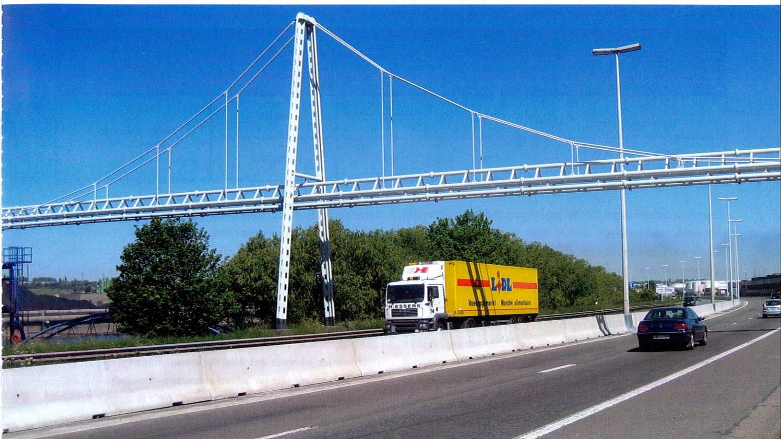
E25 – Wandre – smalle middenberm met lichtmasten – kerend vermogen H4b / Wandre – petite berme centrale avec poteaux d'éclairage – niveau de retenue H4b
