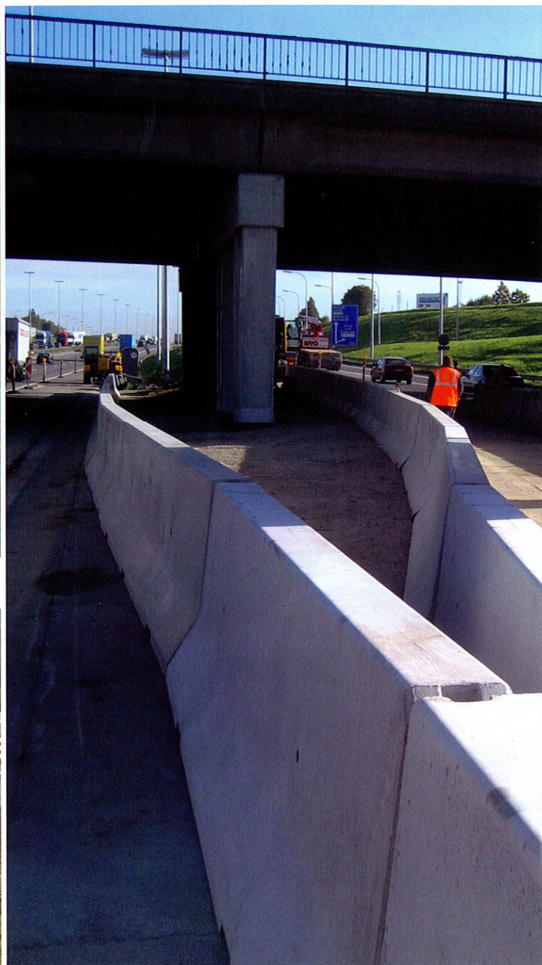
Wemmel – bescherming herstelde brugpijler met kerend vermogen H4b / Wemmel – protection d'une pile de pont réparée avec niveau de retenue H4b
