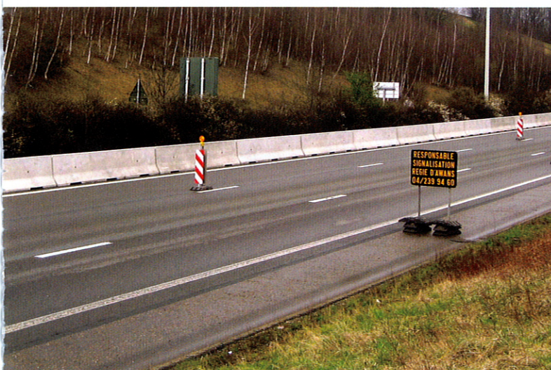
Beveiliging van de middenberm van de viaduct van Boirs – H2 / Sécurisation de la berm centrale du viaduc de Boirs - H2
